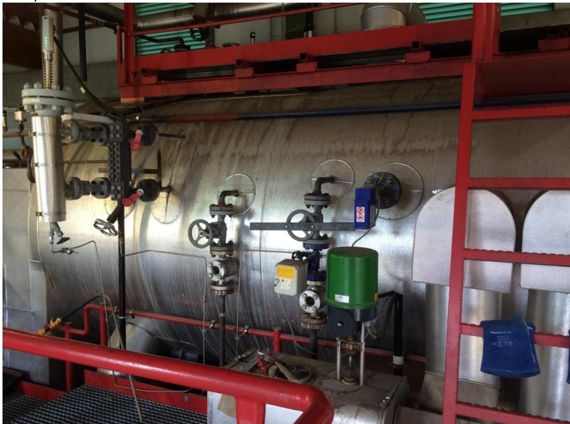
2 Kesselwasserspeisepumpen KSB, 40 bar
